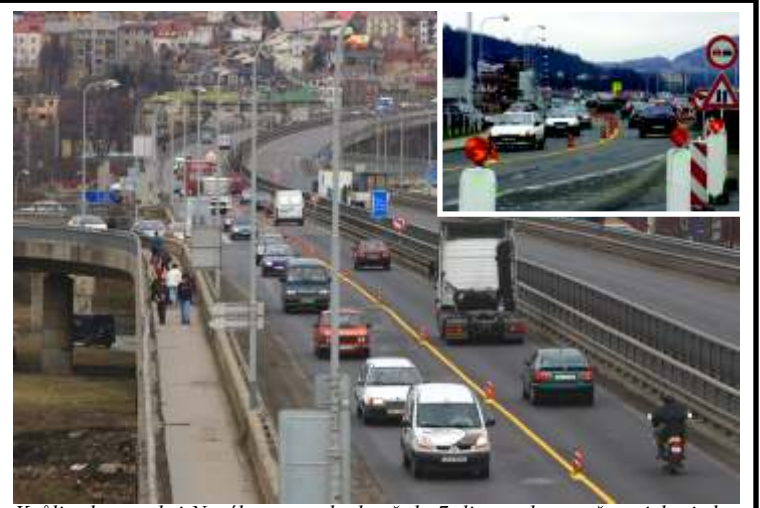
Kvůli rekonstrukci Nového mostu bude až do 7. listopadu uzavřena jeho jedna polovina. Konkrétně jde o část od Podmokel na Kamenickou ulici. V souvislosti s tím, je část Kamenické ulice jednosměrná.
