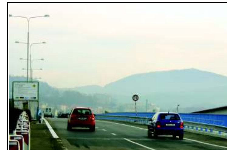
Po nově opravené části mostu začali řidiči jezdit 7. listopadu. Rekonstrukce dalšího úseku v protisměru začne v březnu 2005. Foto: Jan Wetzstein
